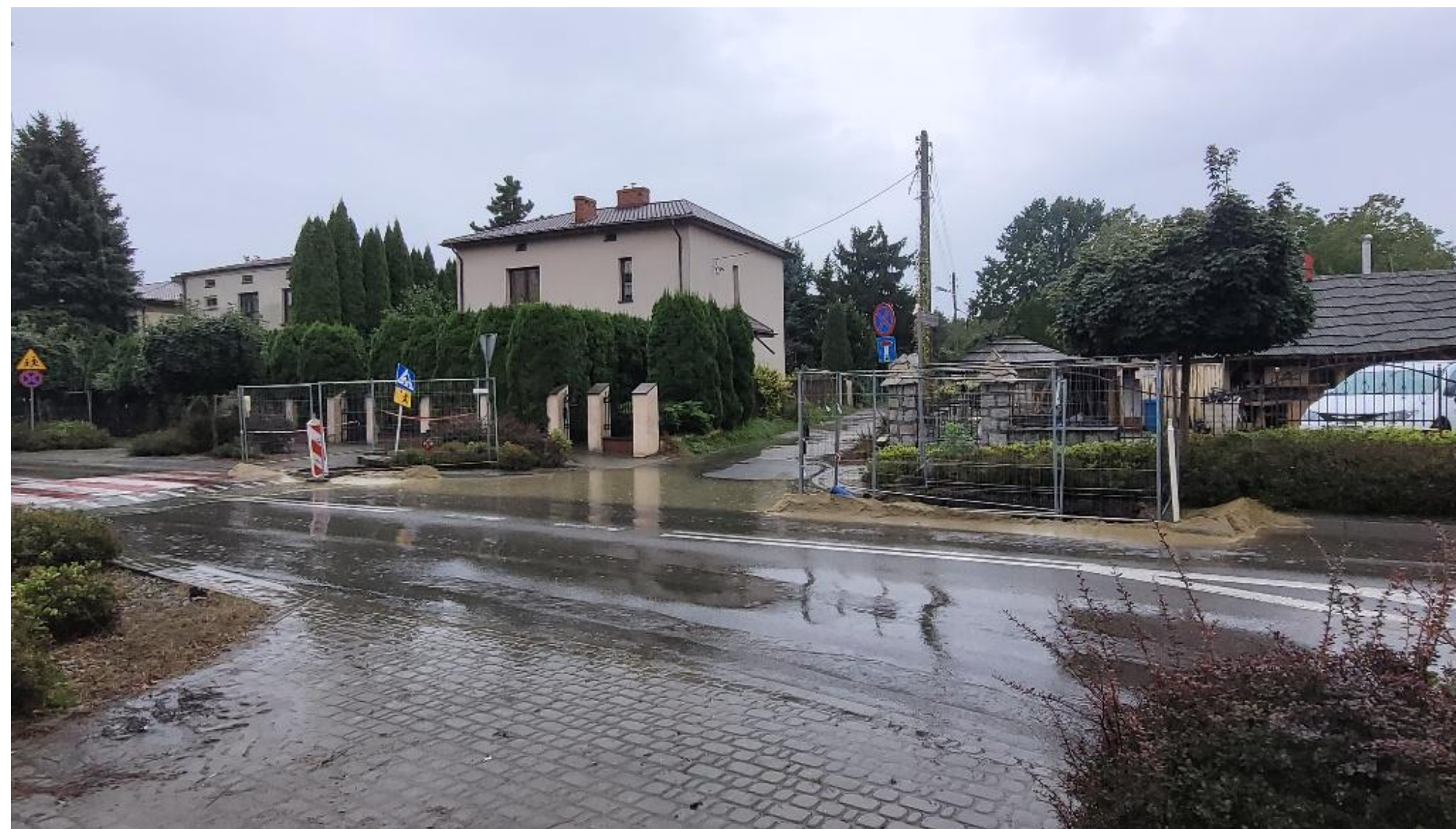
Zabezpieczenie wykopów wykonanych pod sieć wodociągową dn 160 – skrzyżowanie ul. Marszałka Józefa Piłsudskiego z ul. Kasztelańską.
